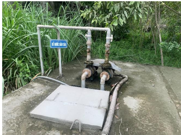
Hình 3.2. Ống thu gom nước dẫn tàu và bể chứa nước dẫn tàu
