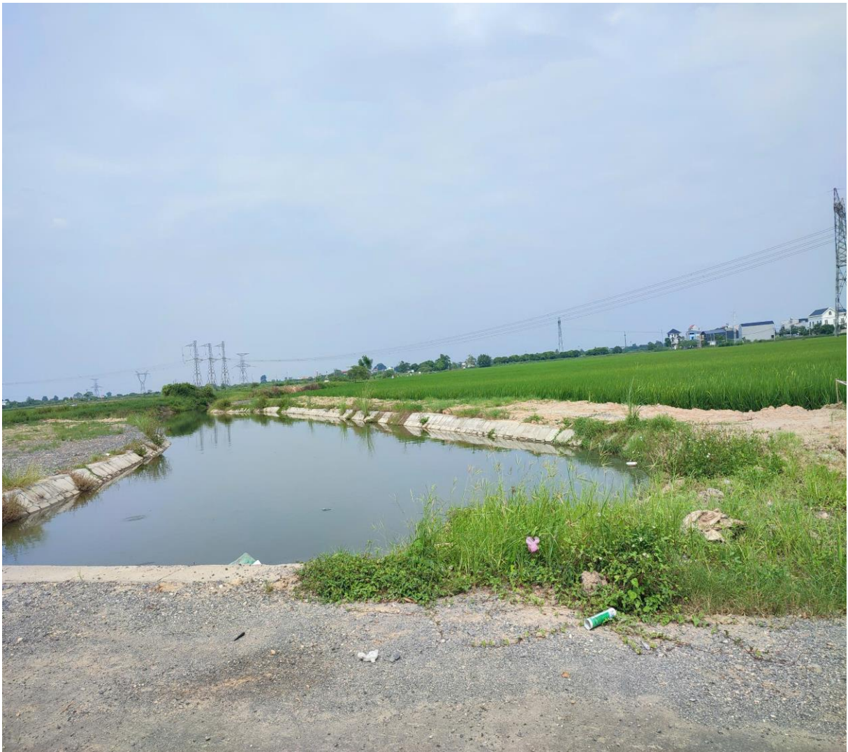
Hình 1.5. Kênh tiêu PK tiếp giáp phía Đông dự án
